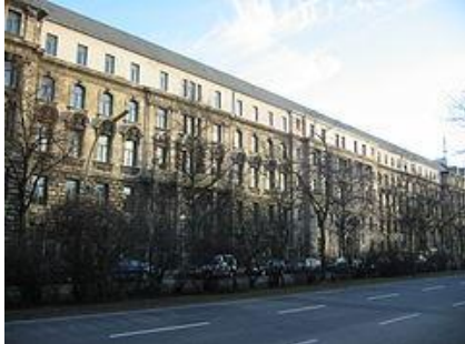
Sitz der Stiftung im ehemaligen Gebäude der Victoria-Versicherung in Berlin-Kreuzberg
